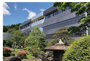
太陽光パネル
