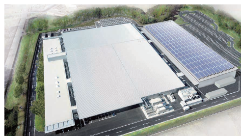
A1 工場と建設中の A1+
