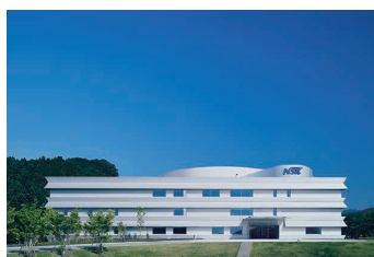
本社棟（RD1棟）
